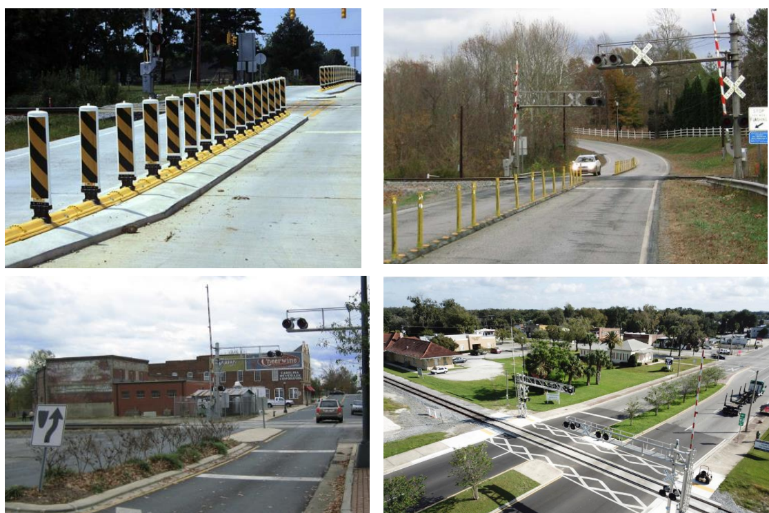
Figura 1 – Implantação de medidas de moderação de tráfego em PNs nos Estados Unidos.
